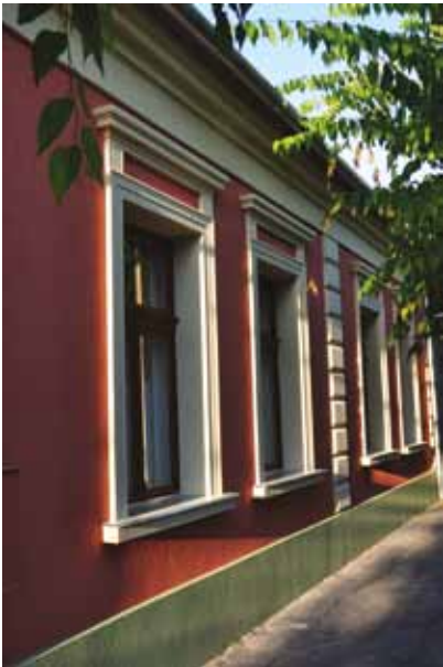
A felújított utcai homlokzat a polisztirolból készített eredeti formákat mintázó díszítéssel, Vác
