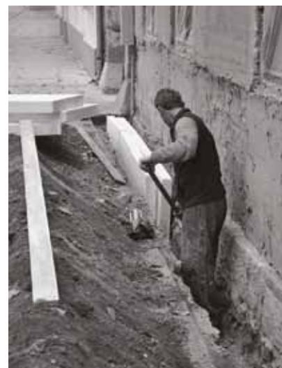
Az alap melletti utólagos hőszigetelés kivitelezése, Vác
